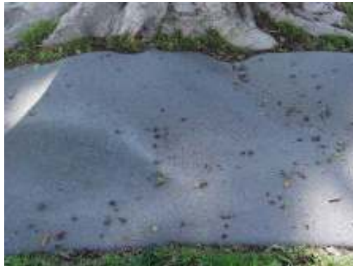
Pour in Place next to tree
